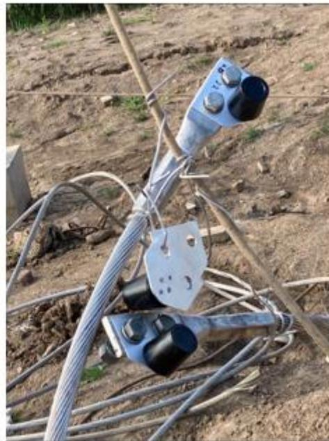
传感器安装于 35kV 输电线路、接收器采用太阳能供电
