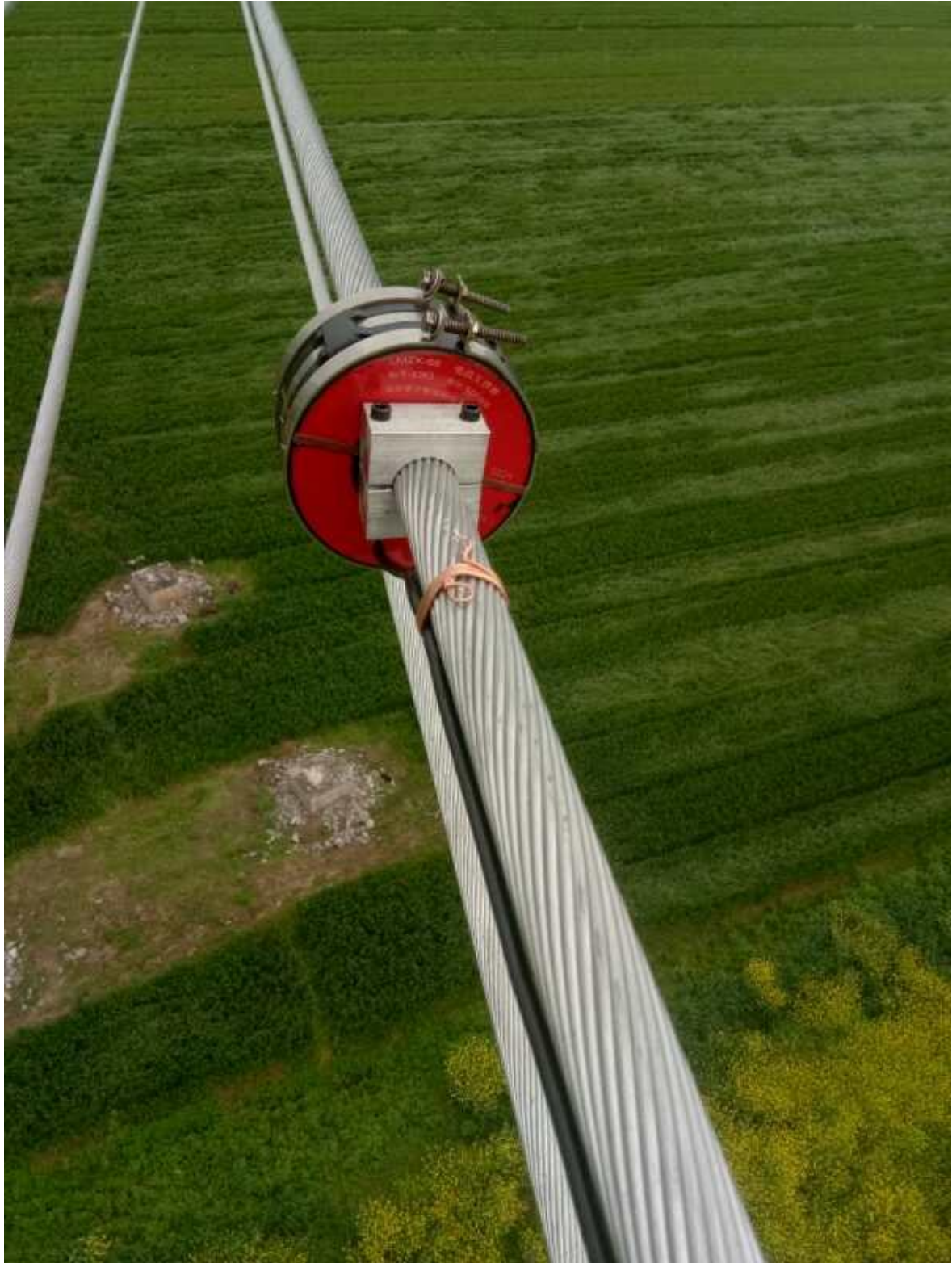
给接收与转发装置供电的 CT 取电装置
