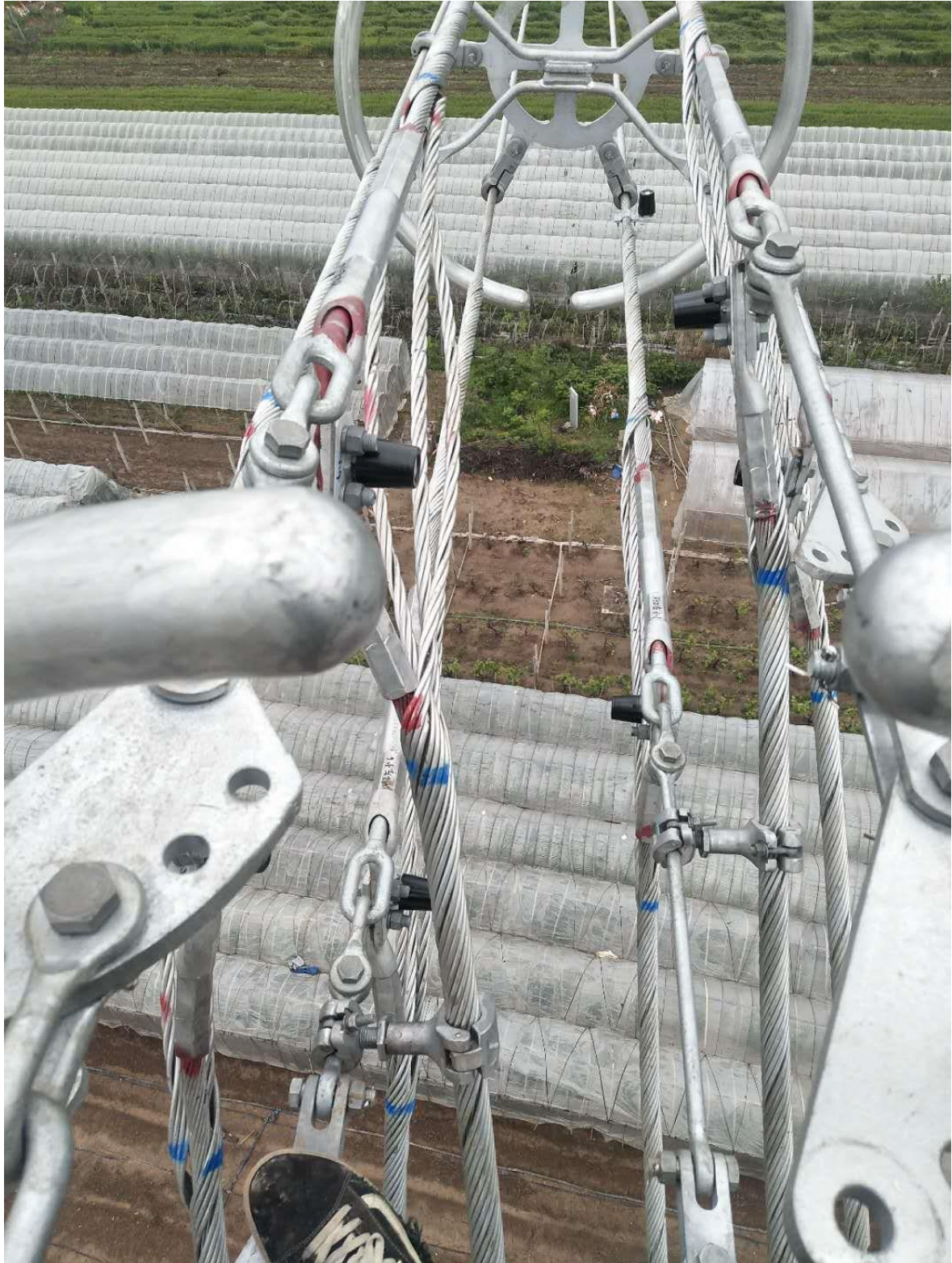
安装在 500kV 输电线路的引流板上
