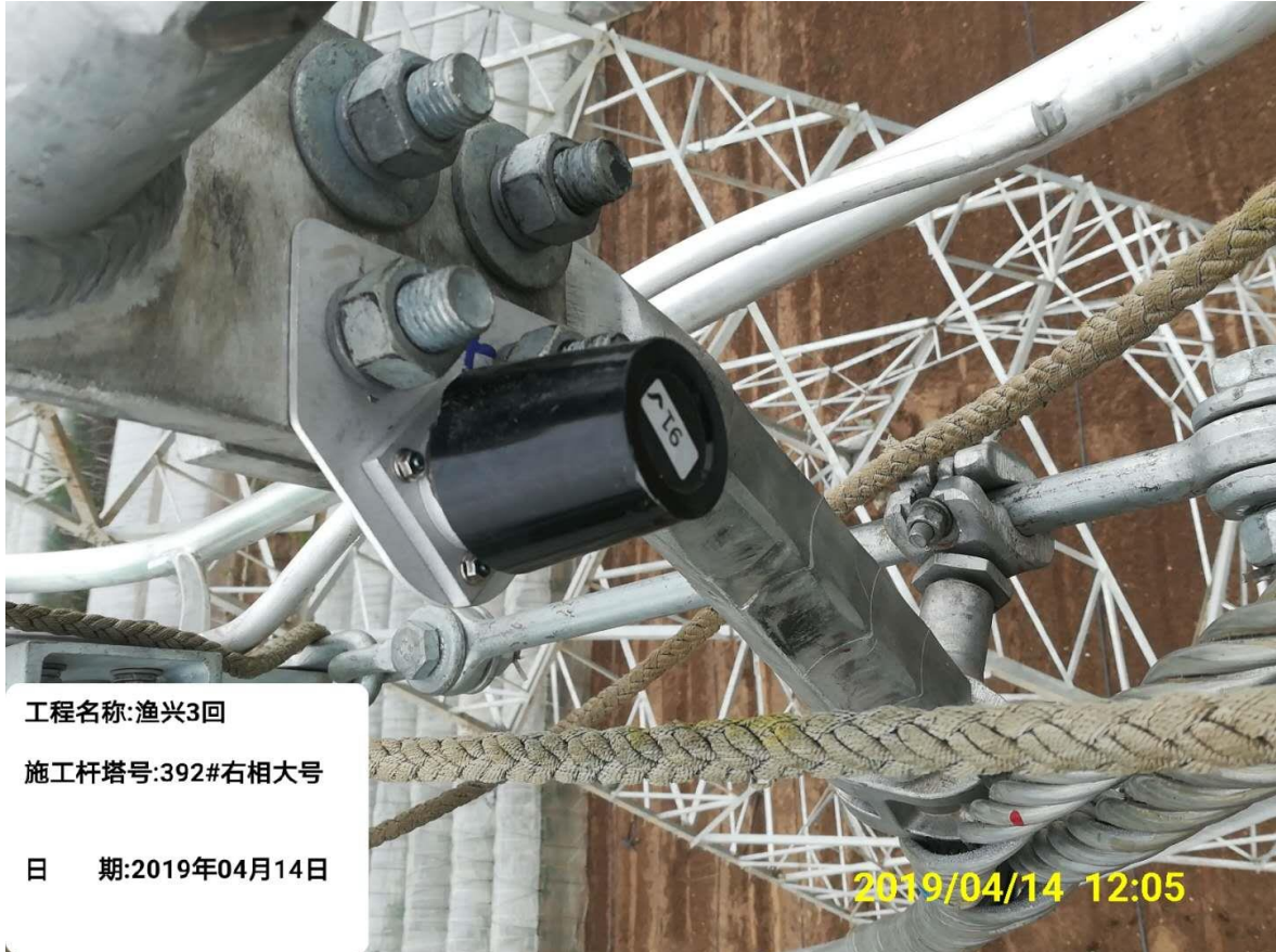
安装在 500kV 输电线路的引流板上
