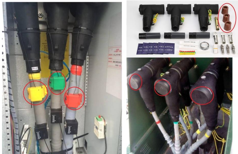
传统的安装方式 传感器安装于电缆外表
